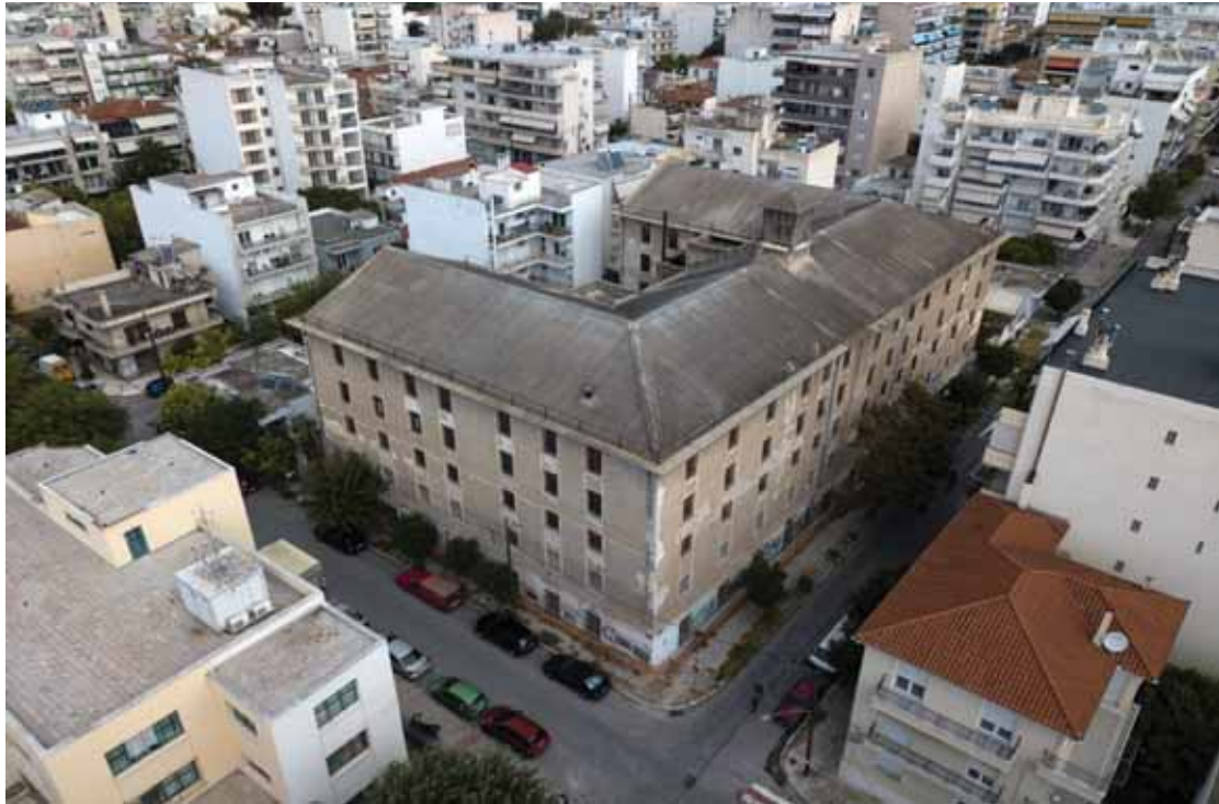
Εικόνα 1. Η Κίτρινη Αποθήκη σήμερα, πριν ξεκινήσουν οι εργασίες ανάπλασης του κτηρίου
